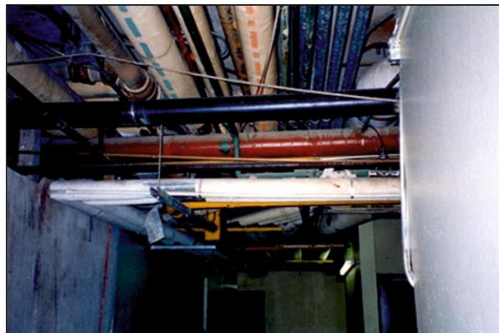
**Şekil 2.1a Elektrik Borularında Oluşan Deprem Hasarı**
